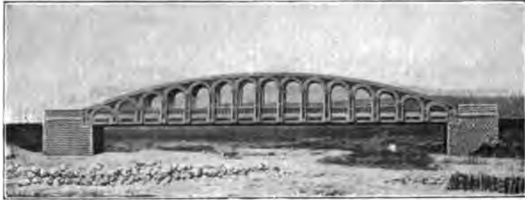
Abb. 86. Béja-Brücke in Tunis.
